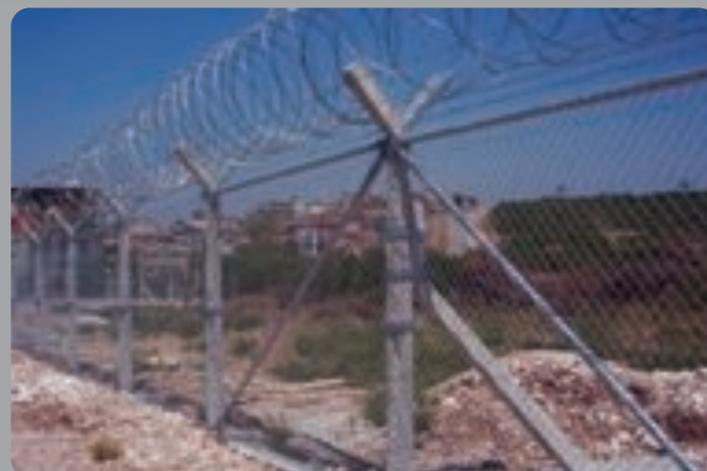
ПРИМЕНЕНИЕ БЕТОННЫХ СТОЛБОВ С РАСТЯЖКОЙ ИЗ ПРОВОЛОКИ С РЕЖУЩЕЙ КРОМКОЙ (350 СМ НАТО)
