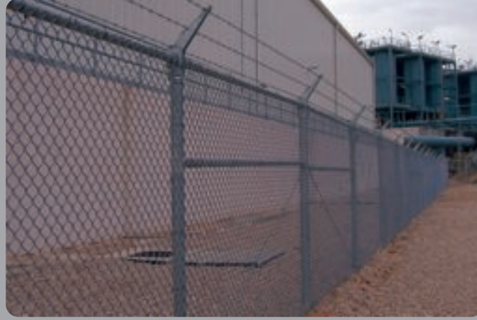
تنفيذ الاعمدة الرؤس المائلة الكلفانيزية
