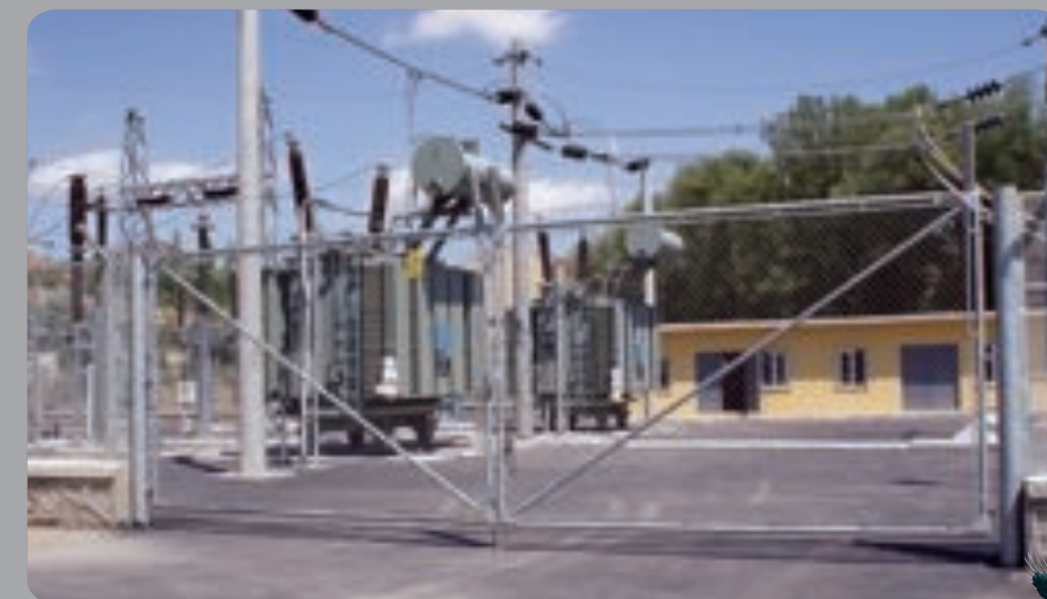
تنفيذ الاطارات البواري والاجنحة المفتوحة الكلفانيزية (٦ M)
