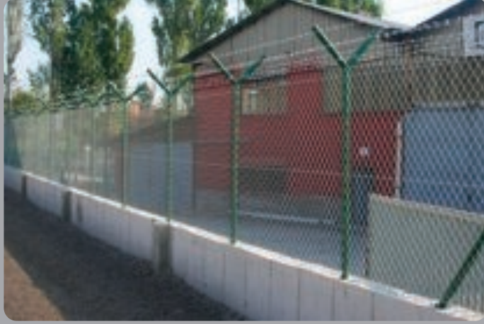
تنفيذ الاعمدة ذو الرؤس الشوكية(الثنائية)
