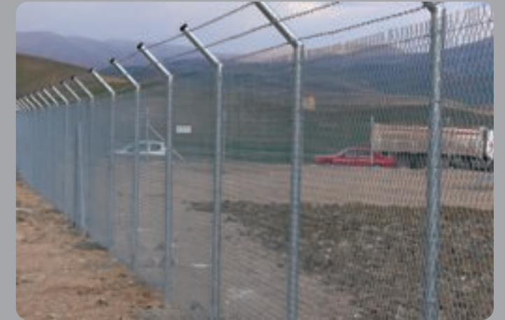
تنفيذ الاعمدة المائلة الكلفانيزية (H: ٣٠٠ CM)
