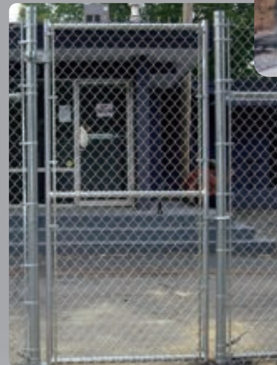
تنفيذ الاطارات البواري والاجنحة المفتوحة الكلفانيزية (M ٨)
