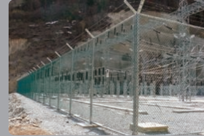
تنفيذ الاعمدة المائلة الكلفانيزية (H: ٣٥٠ CM)
